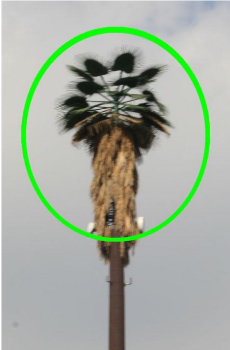
Antena panel sectorial camuflada para celular
